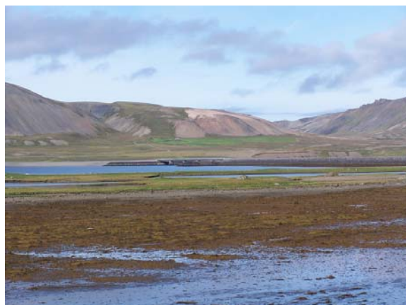
46. mynd. Fjara við Hóp með vegfyllingu og brú yfir Kolgrafafjörð í baksýn. Haustið 2006 áttu þrír staðbundnir minkar heimasvæði í eða við vegfyllinguna, sem virðist hafa verið þeim mikilvæg til fæðuöflunar (ljósmynd: Helen Jewell).
