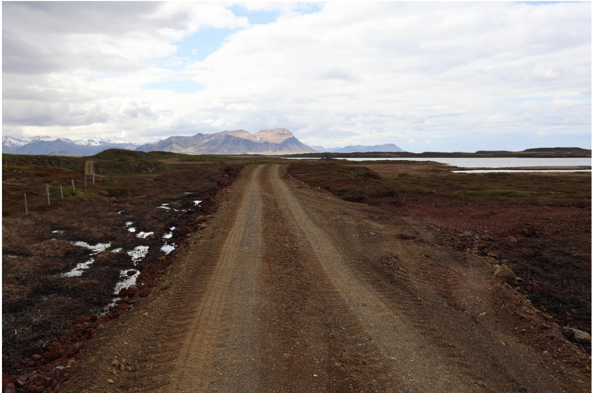
Mynd V3. Vegurinn myndar fyrirstöðu fyrir vatnsrennsli undan halla og safnast vatnið því að einhverju leyti upp vinstra (suðaustan) megin við veginn. Þarna er þó líklega ekki þörf á að setja ræsi í gegnum veginn. Staðsetning skammt suðvestan við VOT821.
