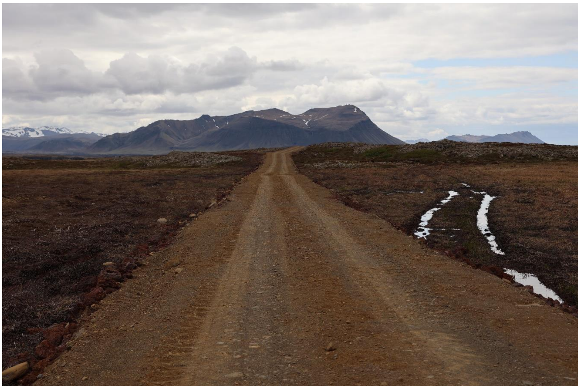
Mynd V15. Vegurinn hefur hér verið lagður yfir votlendi. Sjá má talsverðar skemmdir á votlendisgróðri og -jarðvegi hægra megin við veginn, sem ólíklegt er að jafni sig í bráð. Staðsetning (VOT829): N65.03228° W22.80705°.
