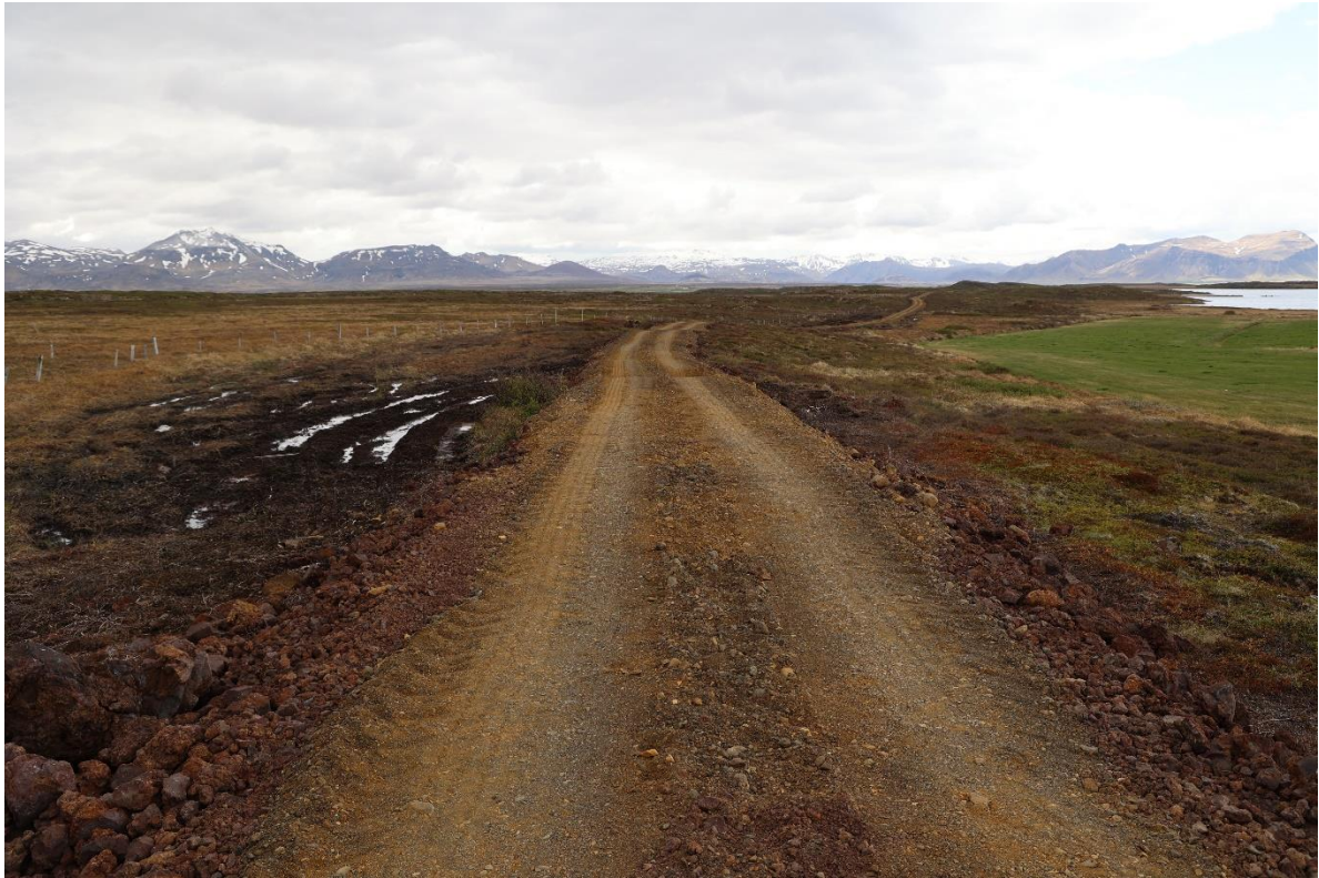
Mynd V1. Vegurinn myndar fyrirstöðu fyrir vatnsrennsli undan halla og safnast vatnið því að einhverju leyti upp vinstra (suðaustan) megin við veginn. Þarna gæti átt við að setja lítið ræsi í gegnum veginn. Staðsetning (VOT819): N65.04360° W22.77181°.
