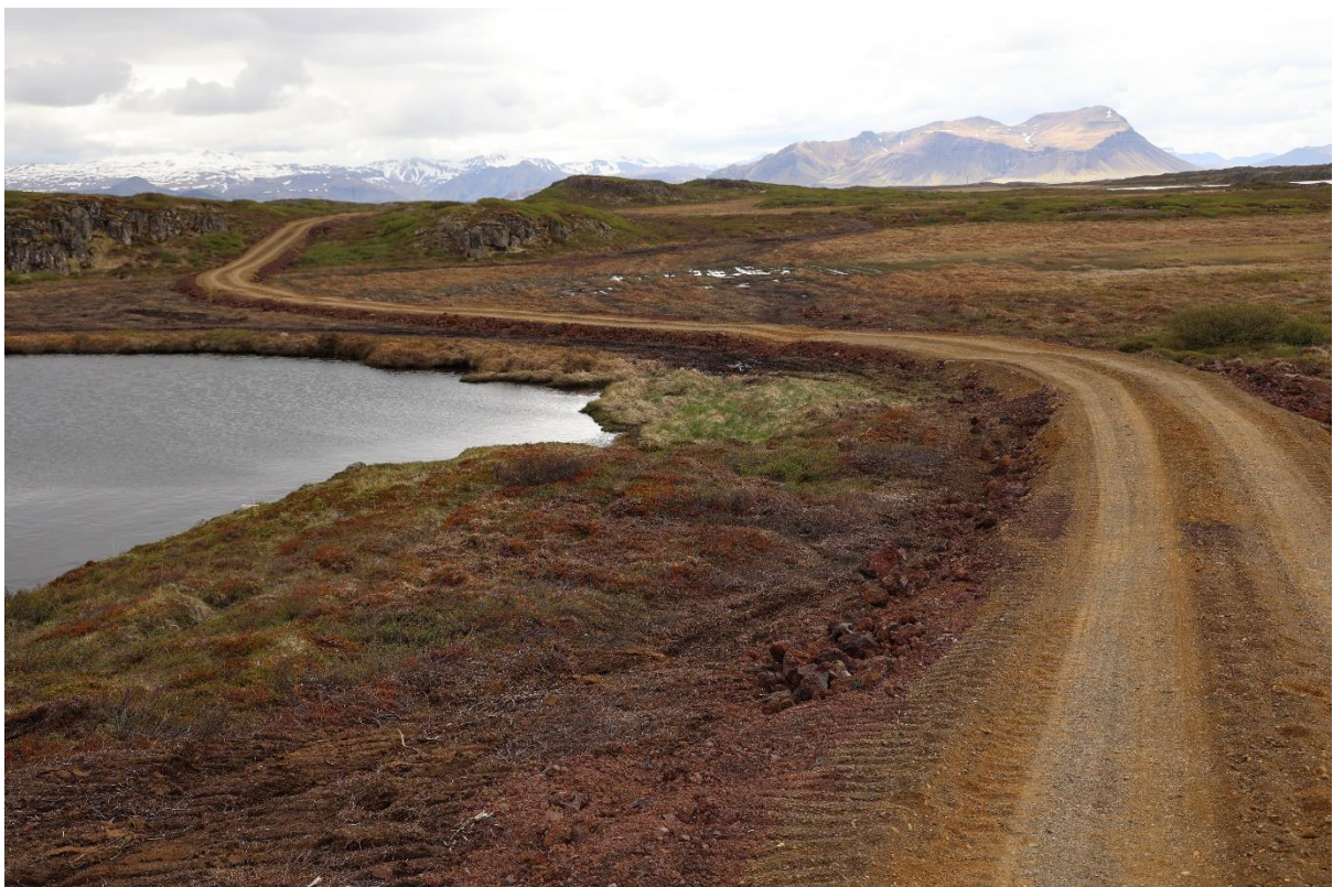
Mynd V4. Vegurinn liggur yfir votlendi á milli Hofstaðavatns (til vinstri) og Ögurvatns. Þarna gæti átt við að setja lítið ræsi í gegnum veginn. Staðsetning (VOT822): N65.03947° W22.78304°.
