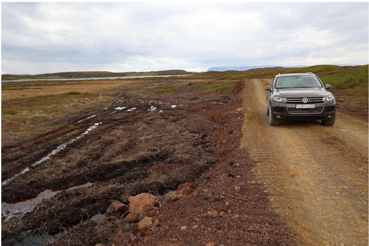
Mynd V8. Vegurinn liggur hér yfir votlendi. Miklu flatarmáli votlendisgróðurs og -jarðvegs langt út fyrir vegstæði hefur verið raskað. Staðsetning (VOT825): N65.03541° W22.79253°.
